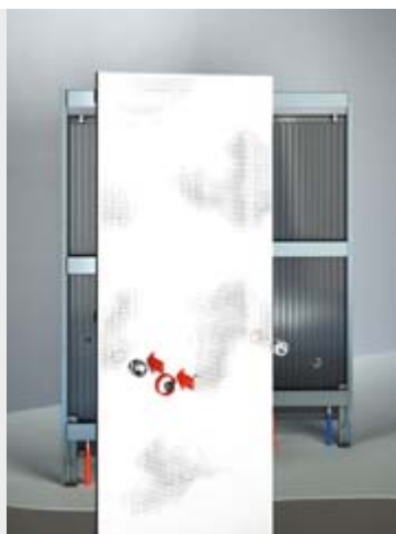
6 Монтаж деталей передних панелей. Монтаж крепежного элемента для полотенцедержателя.
