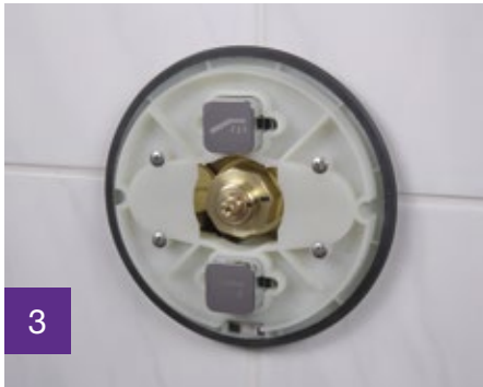
3 Druckknöpfe installieren
