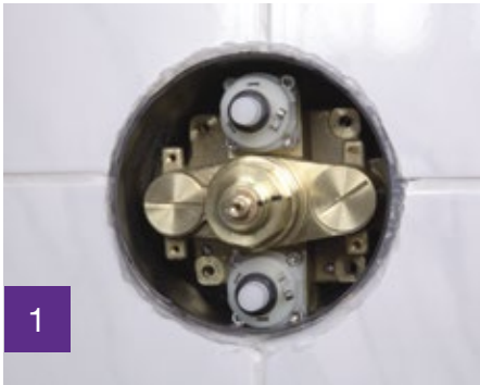
1 Funktionseinheit in die KLUDI FLEXX.BOXX montieren
