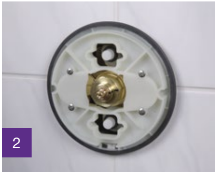
2 Montageplatte installieren
