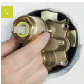
9 Монтаж функционального элемента.
