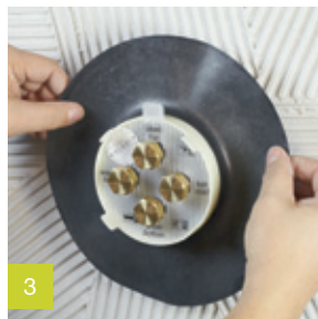
3 Нанесение штукатурки и приклеивание уплотнительной манжеты.
