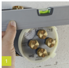
1 Установка встраиваемого элемента.
